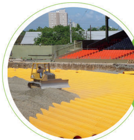
7 Recobrimento com cascalho
