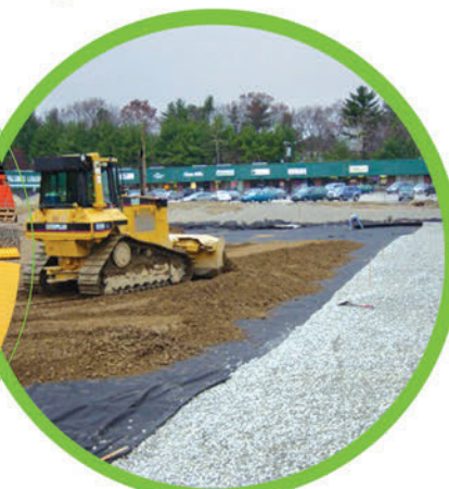
8 Recobrimento final
