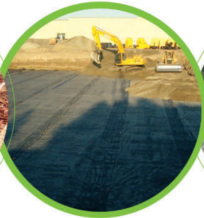
2 Colocar Geotêxtil
