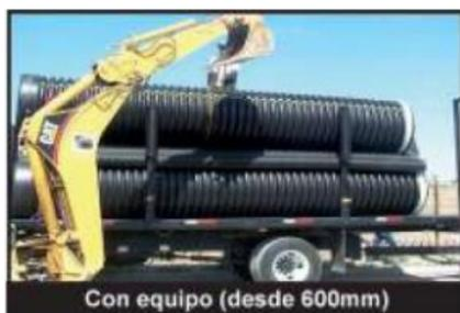
La tubería está diseñada para soportar el manejo normal de la obra y puede ser fácilmente descargada a mano (diámetros hasta 450mm) o con equipo (600mm hasta 1500mm) haciendo uso de bandas de nylon de 50mm o 75mm, o estrobo de plástico. El uso de cualquier material metálico como cadenas o cables de acero No se recomienda, ya que, pueden dañar la tubería
