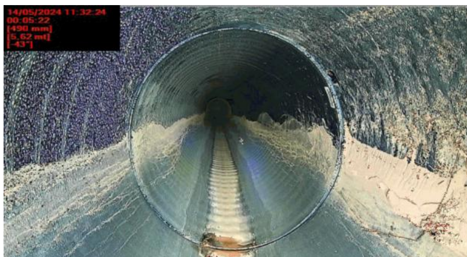
Figura 22 – Fotografia interna da tubulação inspecionada em Santana de Parnaíba/SP.
