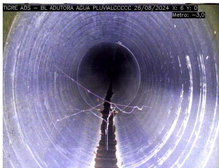
Figura 24 – Fotografia interna da tubulação inspecionada – sistema de drenagem de águas pluviais, em Limeira/SP.
