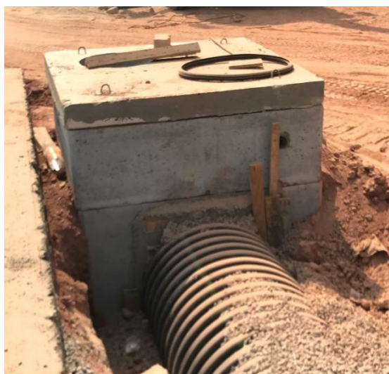
Figura 4 – Chegada do tubo de polietileno ao poço de visita de concreto.
