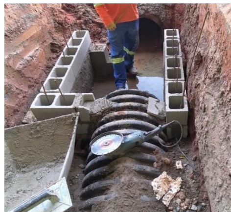
(b) Tubulação na caixa de inspeção (Guarulhos/SP)
